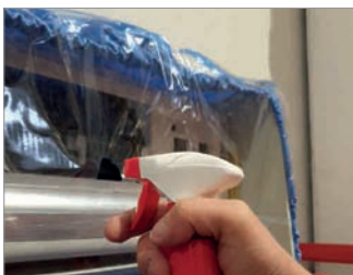
PULIZIA BATTERIA TRAMITE FORO INSERIMENTO SPRUZZINO
