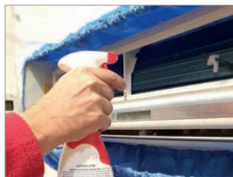
PULIZIA BATTERIA SENZA TELO DI PROTEZIONE
